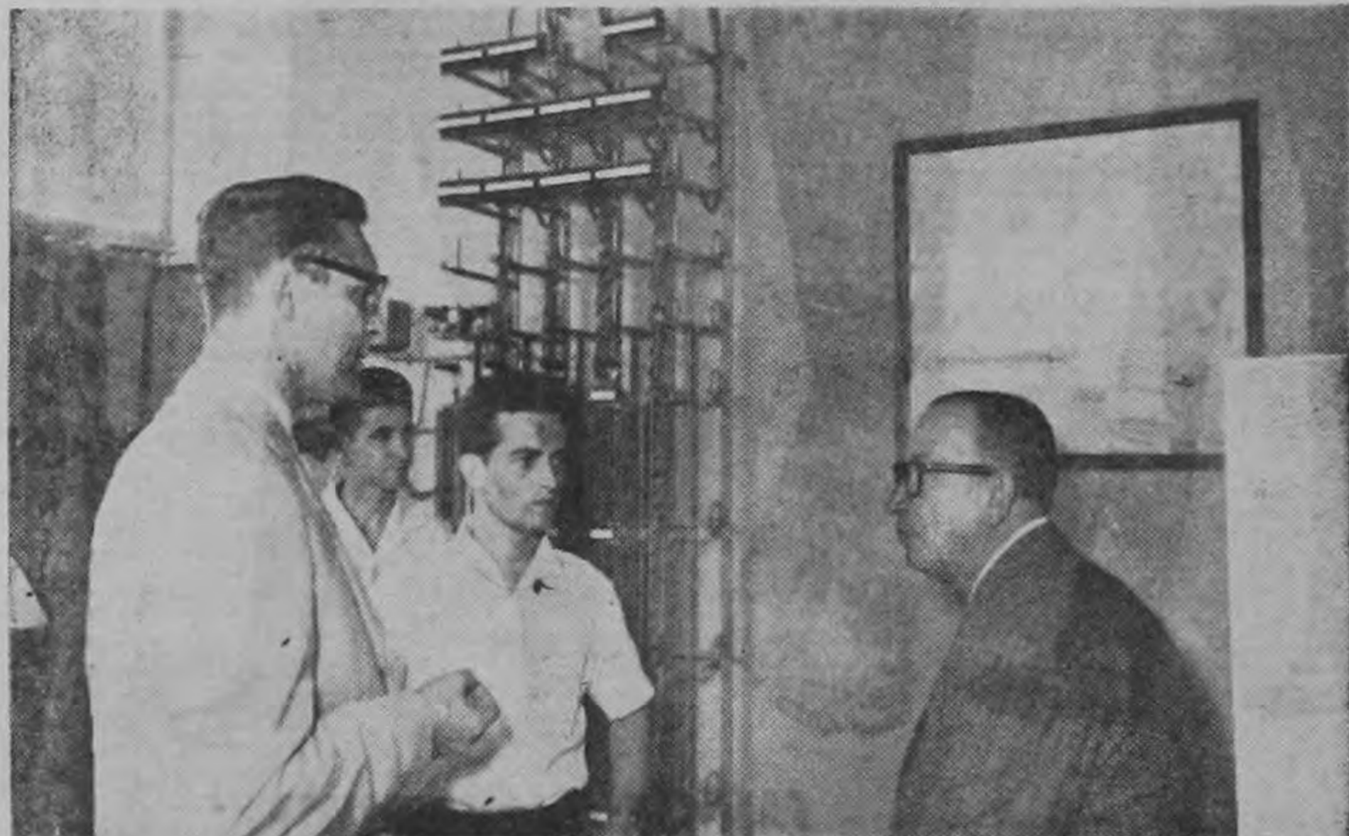
Los ingenieros Schubert y Kolbe de Siemens de Centroamérica, Ltda., firma que realizó la instalación de la nueva central automática SIEMENS en conversación con el señor Presidente, don Francisco J. Orlich.
